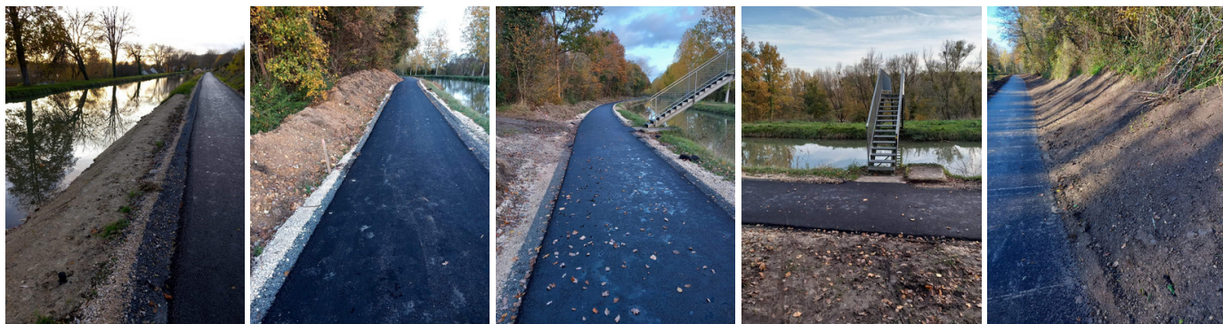
Le travaux le long du Canal de Berry à Châtillon-sur-Cher
